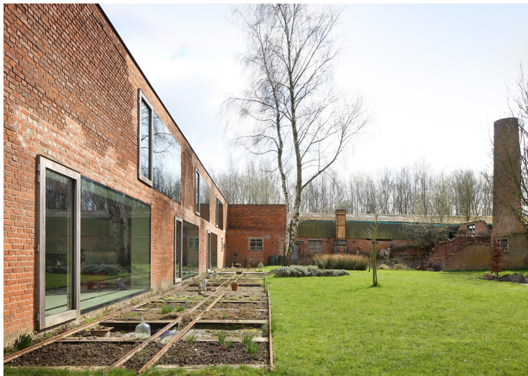
De lege gebouwen bleven gevrijwaard, zodat het verhaal van de steenbakkerij nog verteld kan worden. © Filip Dujardin
